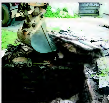
Sollevamento delle superfici in cemento con macchine escavatrici
